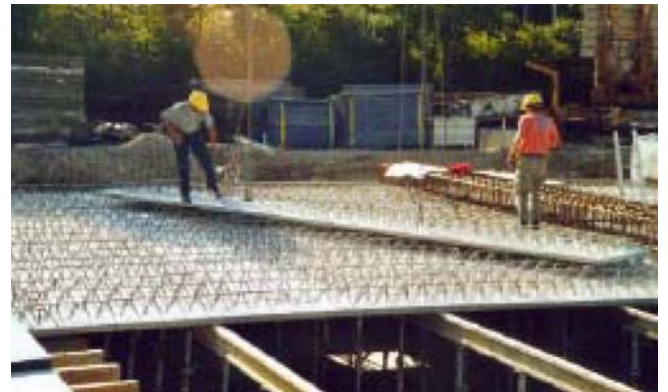
Herstellung der Decke – Einschwenken der Filigranplatten
