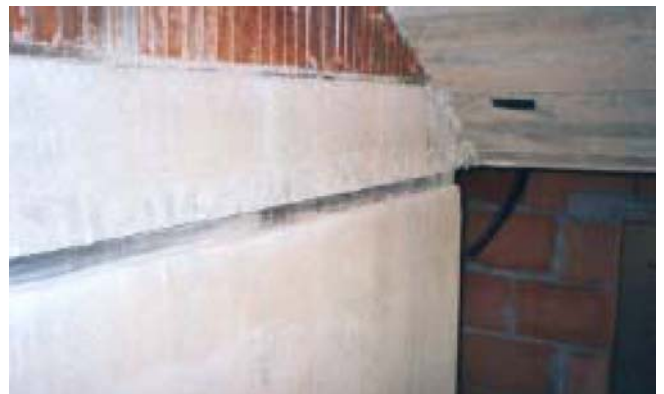
Lagerfuge im Rohzustand
