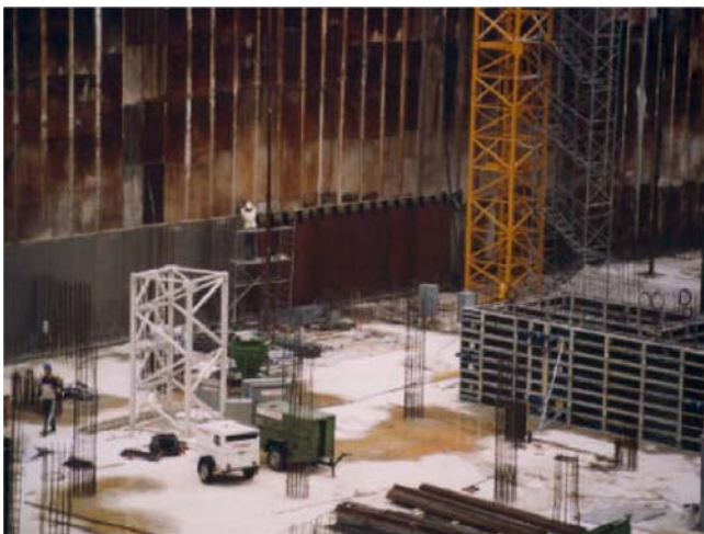
Das Bild zeigt die Montage der seitlichen Abschirmung beim Bauvorhaben Friedrichstadt-Passagen in Berlin.
