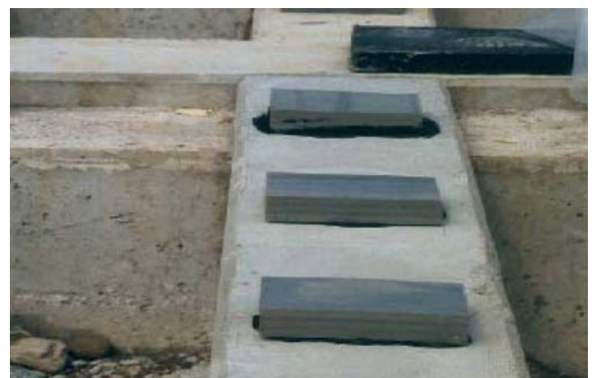
Das Bild zeigt auf einem Streifenfundament verlegte Punktlager.
