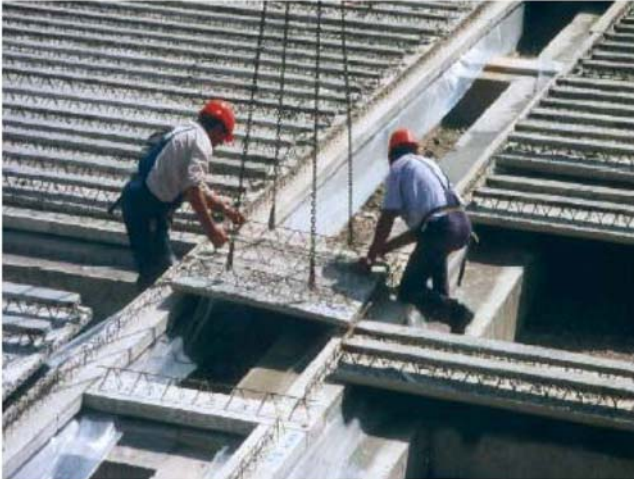
Verklebung der Lager mit bituminösen Kleber auf dem Untergrund
