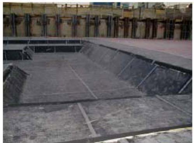
BV Belsheim Center – Im ersten Abschnitt eingebaute Matten.
